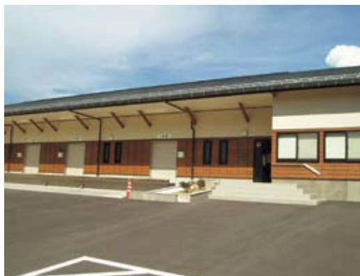
平成19年11月完成の加工場外観
