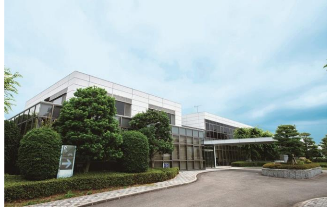
テクノプラザ愛媛別館
