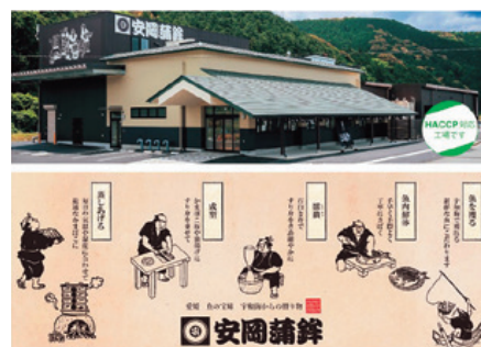
安岡蒲鉾 新工場が完成しました
