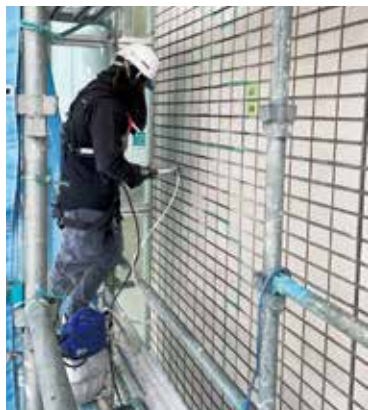
現場作業風景
