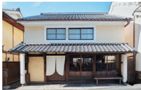
古民家ゲストハウス&バー「内子晴れ」建物正面
